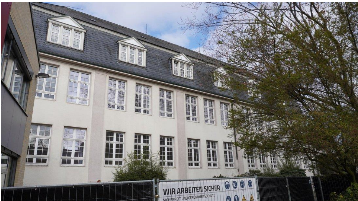
Blick am Freitagvormittag auf das Gebäude A des Kreisgymnasiums Haselünne, bevor es in den nächsten Tagen und Wochen dem Erdboden gleich gemacht wird. Foto: Daniel Gonzales-Töpper
