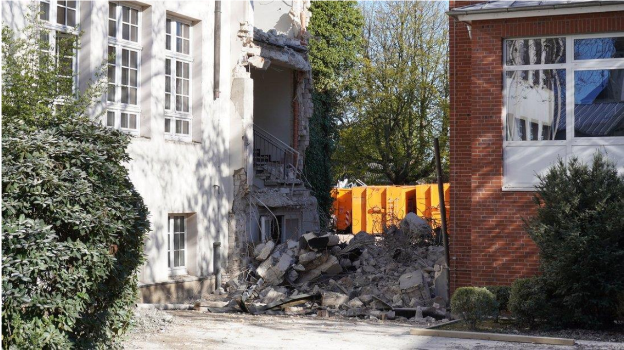
Der Verbindungsgang zum Schulgebäude an der Klosterstraße (rechts im Bild) ist seit Freitagabend bereits entfernt. Voraussichtlich ab Mittwoch fällt dann auch das Hauptgebäude (links) Stück für Stück. Foto: Daniel Gonzales-Tepper
