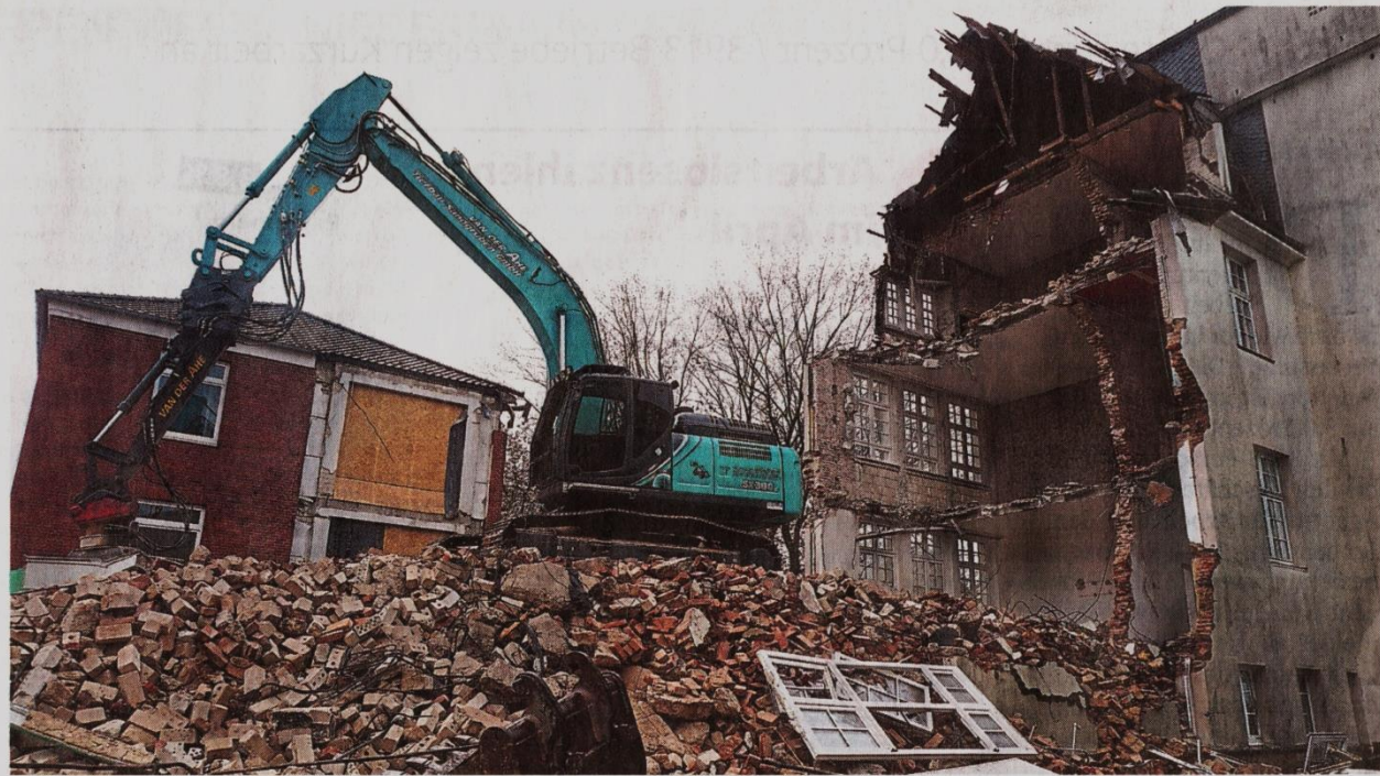
Nun ist das Hauptgebäude dran: Planmäßig schreitet der Abriss des Altbaus am Kreisgymnasium voran.
