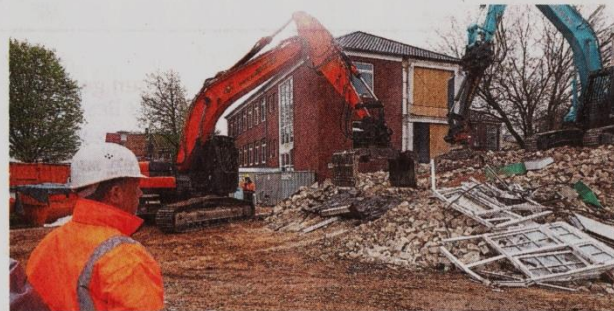
Bauleiter Norbert van der Ahe schaut dem Treiben der beiden Bagger seines Unternehmens auf dem Schulgelände an der Klosterstraße in Haselünne aufmerksam zu.
