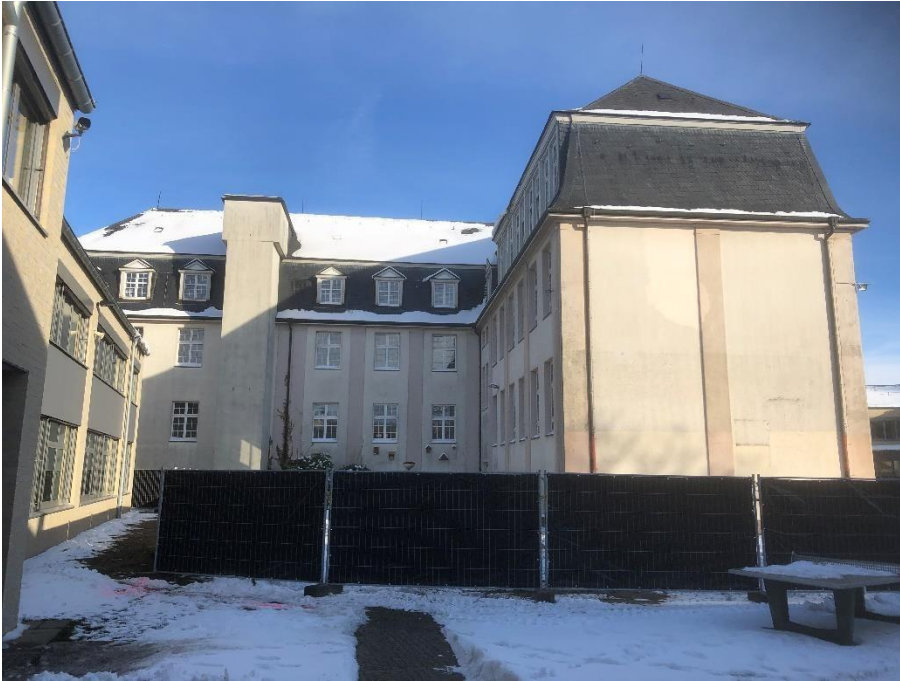
Ansicht von Osten auf den
